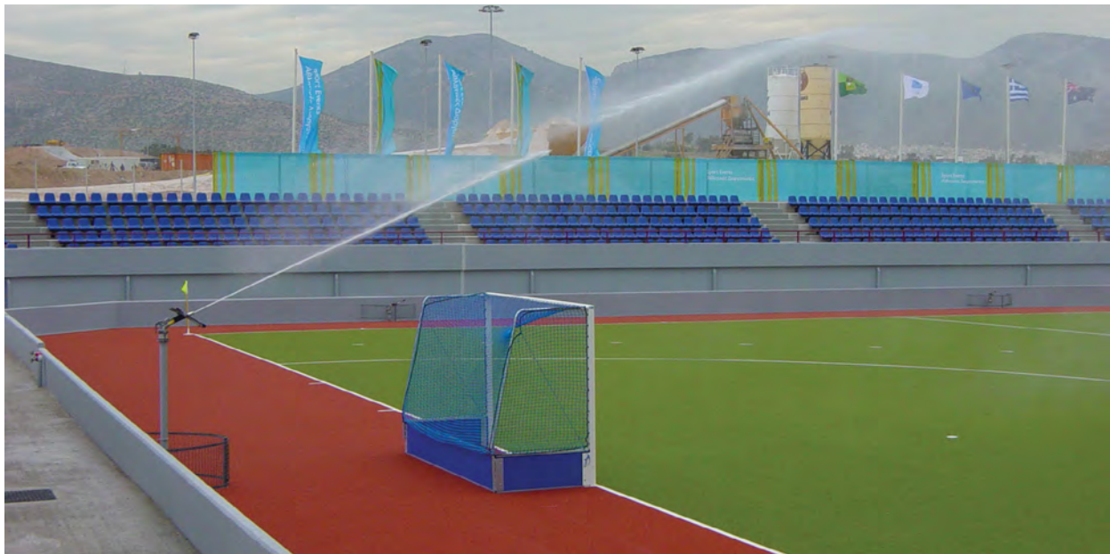
Figura 29. Os aspersores Big Gun® fixos permanente irrigam grama sintética no estádio olímpico de hóquei em Atenas, Grécia.
